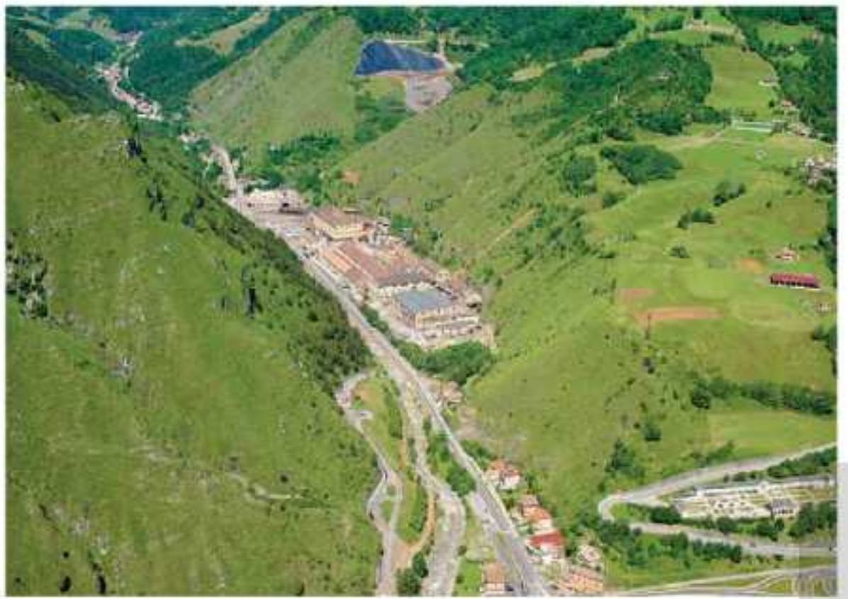
Fig. n. 2. Pontenossa S.p.A Plant., Ponte Nossola (Bergamo).
